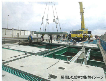
損傷した部材の取替イメージ
