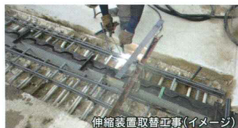
伸縮装置取替工事(イメージ)
