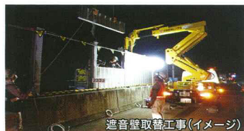
遮音壁取替工事(イメージ)
