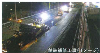
舗装補修工事(イメージ)
