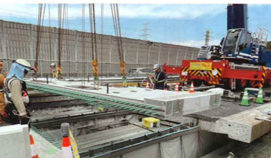
宝塚IC～神戸JCTの工事実施状況
