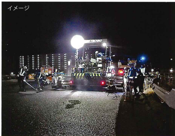
舗装補修工事
