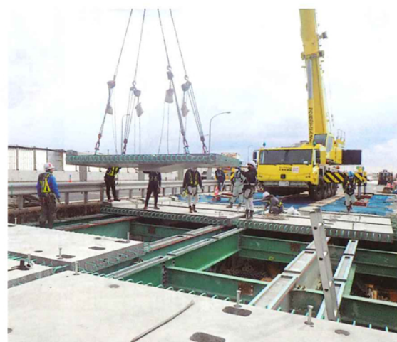
リニューアル工事実施状況
