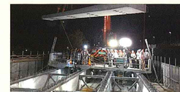
プレキャスト床版の施工
