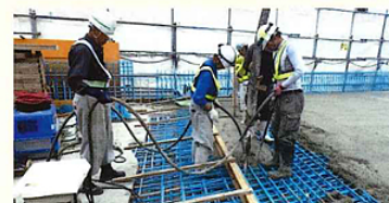
現場打ち床版の施工
