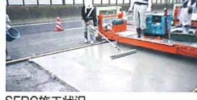
鋼床版の疲労き裂が発生している箇所においては、既存のアスファルト舗装を剛性の高い鋼織維補強コンクリート(SFRC)に置き換えることにより鋼床版の応力を軽減し、疲労耐久性を向上させ、長寿命化を図ります。
