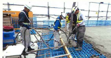
現場打ち床版の施工
