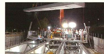
プレキャスト床版の施工
