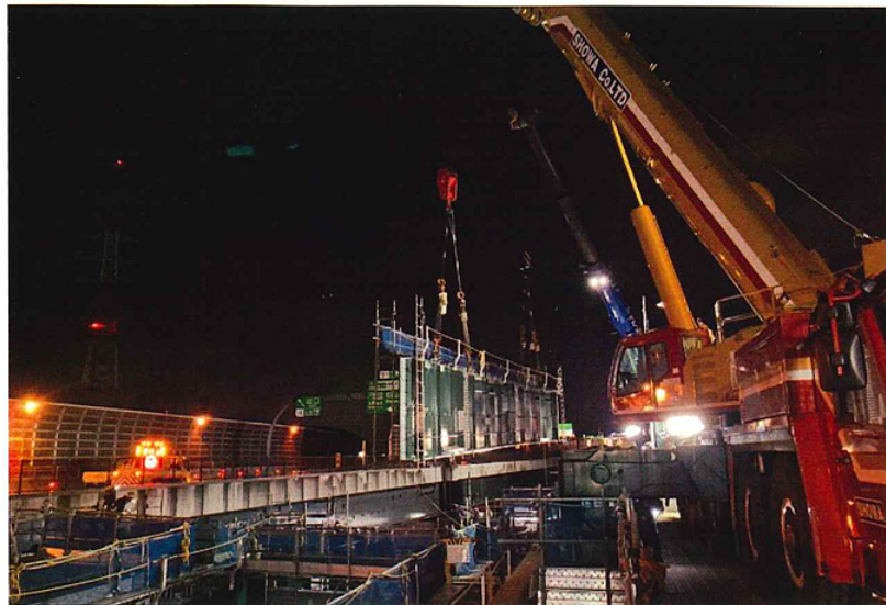
橋梁架設工事の様子
